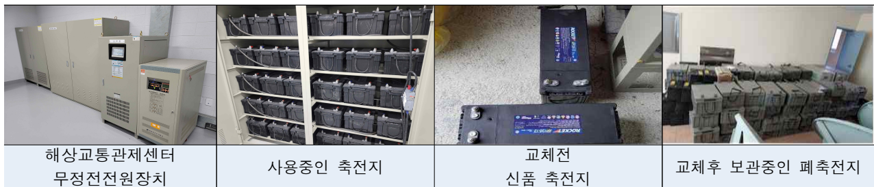
[그림 5] 해상교통관제센터 무정전전원장치 축전기 교체 실태
